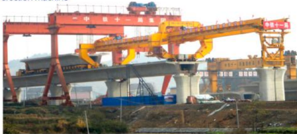
▲ 我公司生产的TQ900过隧架桥机正在中铁十一局沪昆客专项施工工地投入使用。
