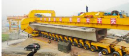
▲ 我公司生产的TQ900过隧架桥机正在中铁十六局成渝客专项施工工地进行组装。
